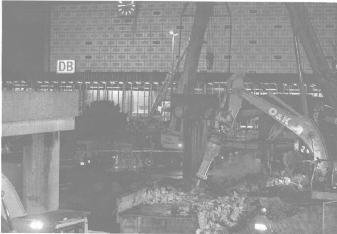
Routiniertes Zerstörungswerk. Die Brücke am Bahnhof sinkt dahin.
