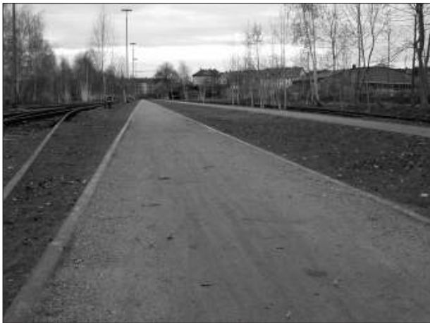
» Aufgefüllter Schienenstrang
