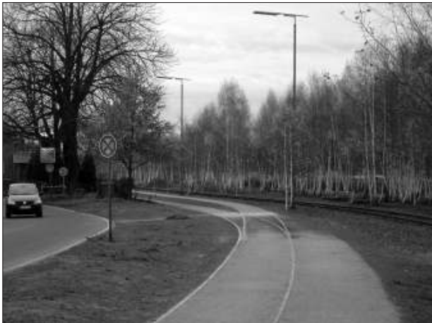
» Aufgefüllter Schienenstrang inkl. Weichenbereich
