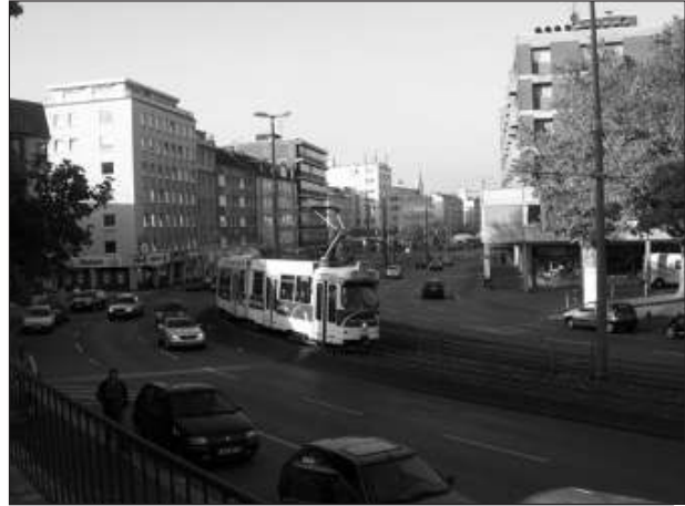
» Der Aegidienmarkt würde mit Gelder des RSB-Ausbaus umgebaut. Für Fußgänger entsteht eine Querung.
