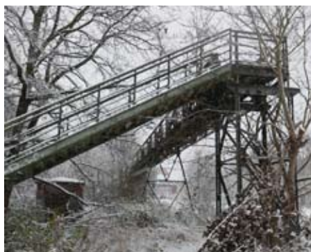
Fußgängerbrücke am Luftschifferweg
