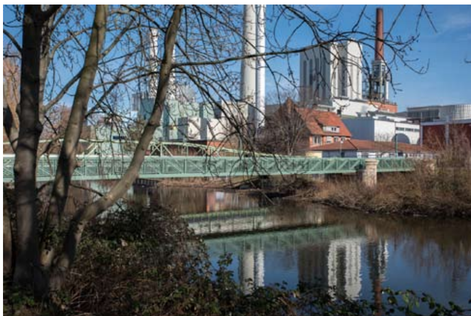
Okerbrücke Nord mit Blick auf das Heizkraftwerk Mitte
